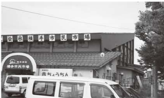
▲斜め屋根の市民市場建物
